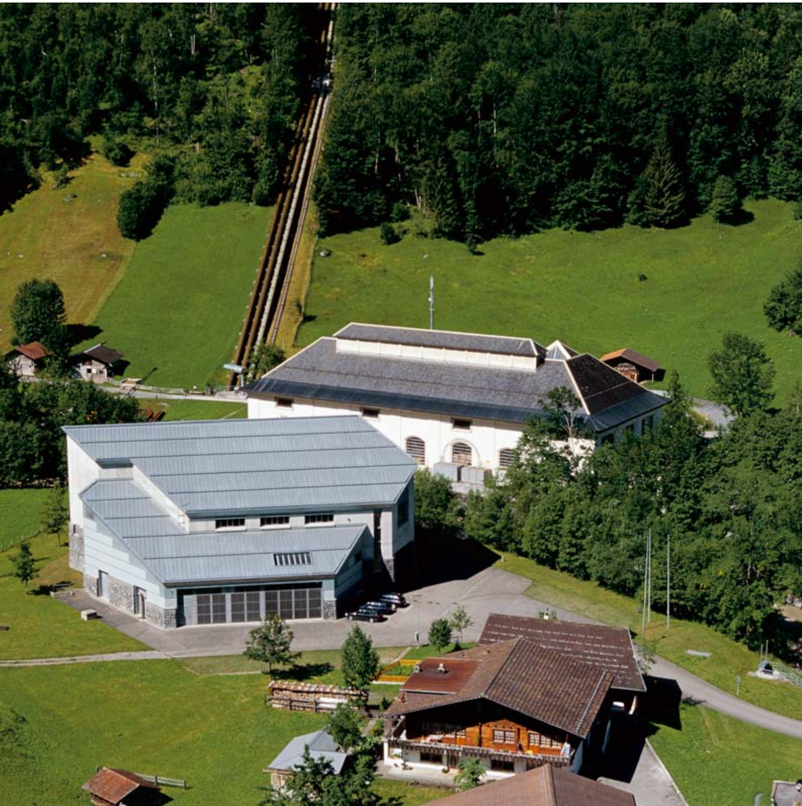
Kraftwerk Kandergrund mit Druckleitung und altem Maschinenhaus
